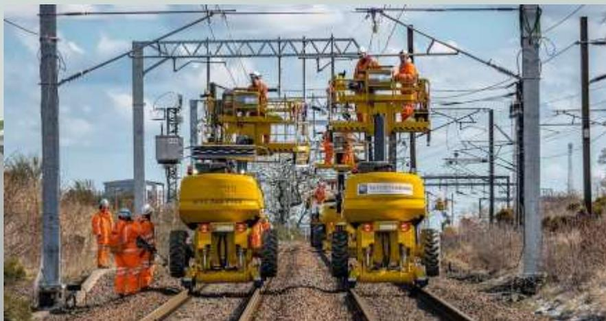
**ЖЕЛЕЗНОДОРОЖНАЯ ЭЛЕКТРИФИКАЦИЯ** – оборудование действующих и вновь строящихся дорог, комплексом устройств, обеспечивающих использование электроэнергии для поездов.
